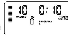
Ciclo de la estación 10 en funcionamiento
