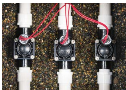
Zainstalowany PGV-100G
